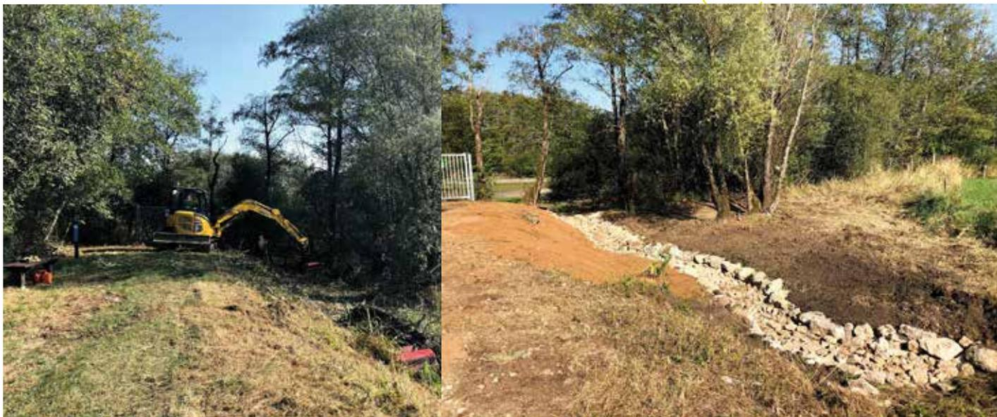
Tout d'abord, c'est la sortie de l'étang des Alaines qui a été dégagée et réaménagée pour faciliter l'écoulement de l'eau sur un cours reméandré par l'apport et la mise en œuvre de matériaux calcaires qui offre une diversité d'habitat à la faune aquatique.
