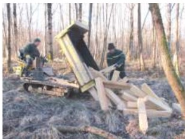
1. Acheminement des matériaux (bois, chêne non traité) à l'aide d'un petit chenillard
