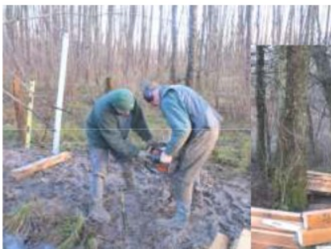
3. Préparation des trous à la tarière thermique en vue de la pose des pieux
