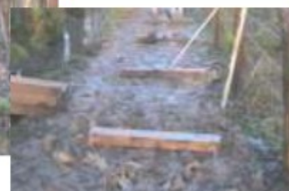
5. Pose des traverses sur les deux pieux
