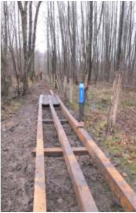
6 . Pose des trois longerons sur les traverses
