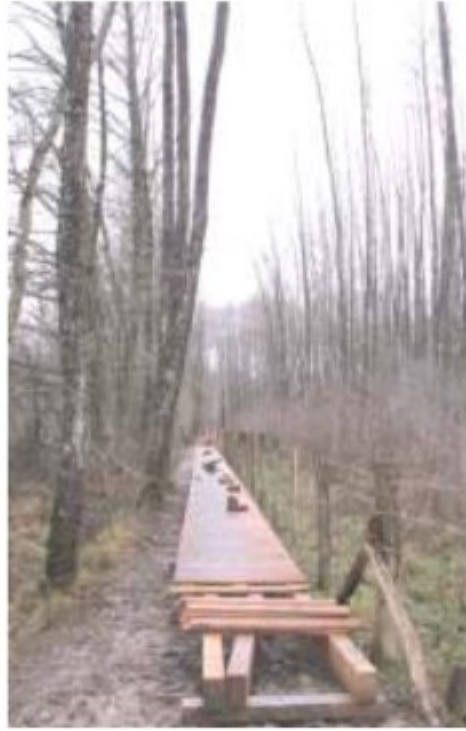
7 . Pose et vissage du platelage
